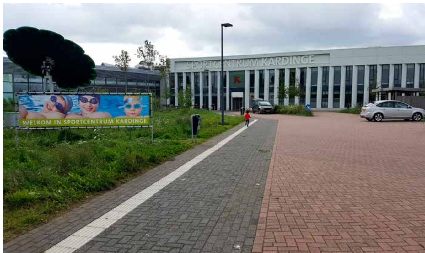
"De afgelopen jaren hebben we een keur aan werkzaamheden mogen uitvoeren voor Sportcentrum Kardinge. Van de regeltechniek voor de verwarmings- en koelinstallaties t/m de zwembadinstallatie."
